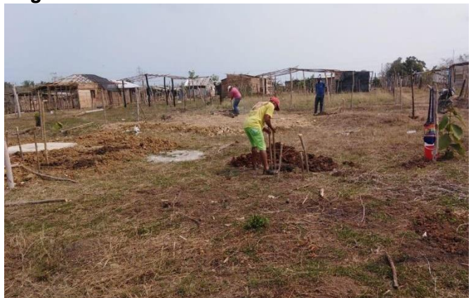
Fotografía 12. Construcción de viviendas rurales
