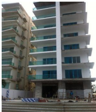
Figura 4. Edificaciones en altura
